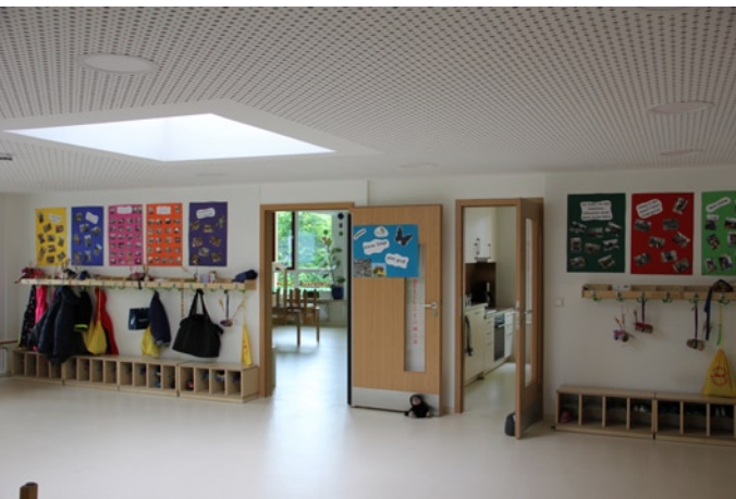
Auch die Lichtkuppel im Foyer des Kindergartens geh rt zum Sanierungsumfang und macht den Kindergarten schon beim Empfang schon hell und freundlich.
