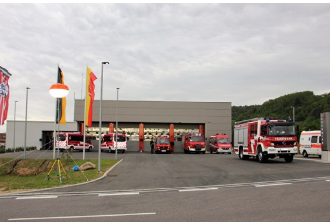
Am vergangenen Wochenende konnte die feierliche Einweihung des Feuerwehrhauses am Standort 2 in Obersulm sowie ein „Tag der offenen Tür“ begangen werden. Im Bild ein Teil der Fahrzeugflotte der FFW Obersulm.
