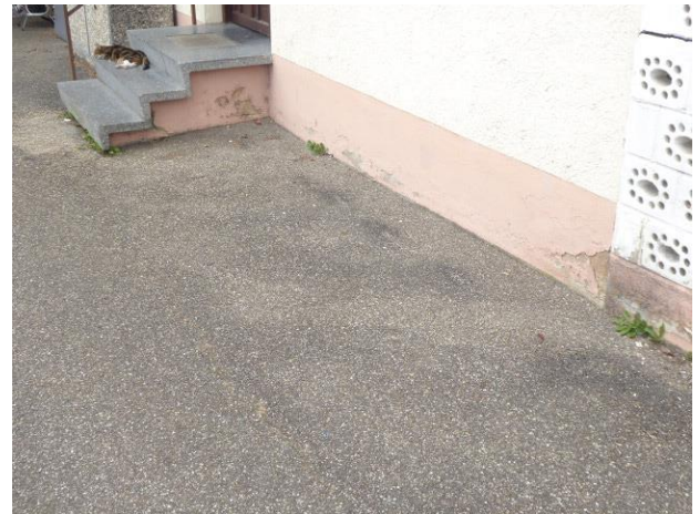
Abb. 17: Asphaltierter Vorplatz vor dem Wohnhaus ohne Spuren tierischer Nutzung (Kotpartikel z.B.).
