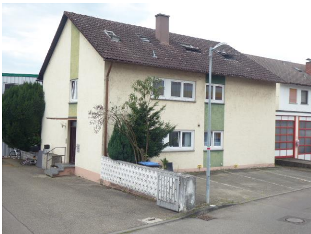
Abb. 14: Wohngebäude aus nordöstlicher Richtung und asphaltierte Umgebung.
